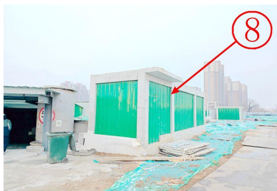
项目内未拆除建筑
