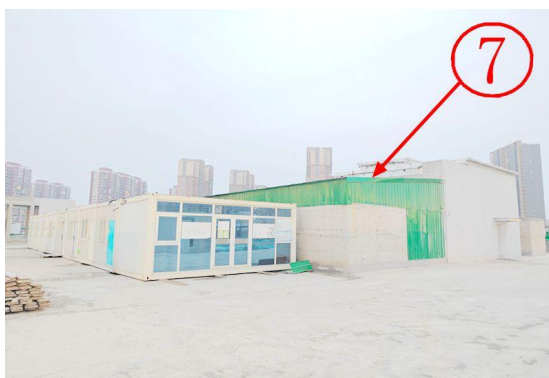
项目内未拆除建筑
