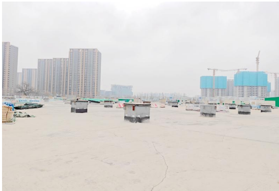
项目内基地平台
