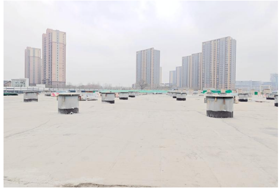
项目内基地平台
