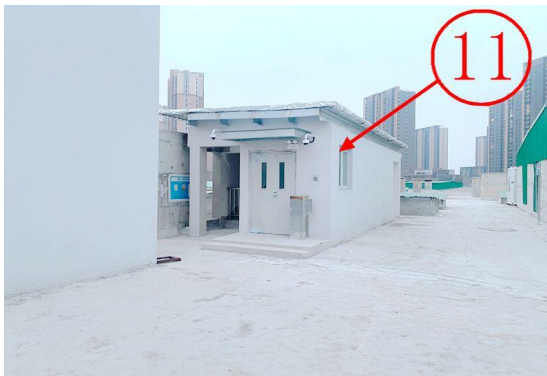
项目内未拆除建筑
