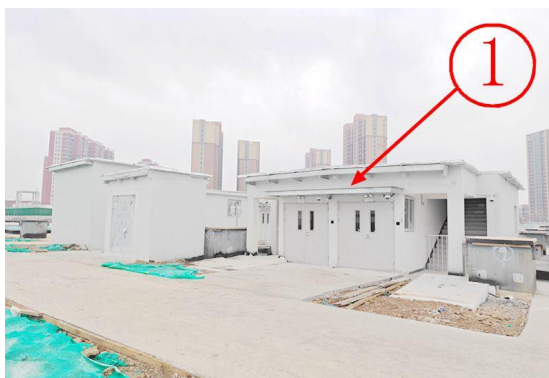
项目内未拆除建筑
