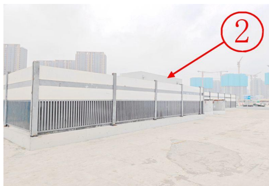
项目内未拆除建筑
