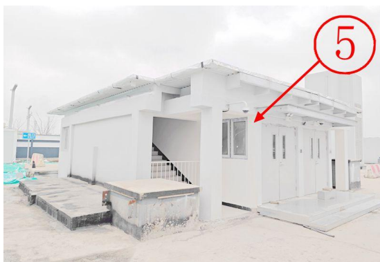
项目内未拆除建筑
