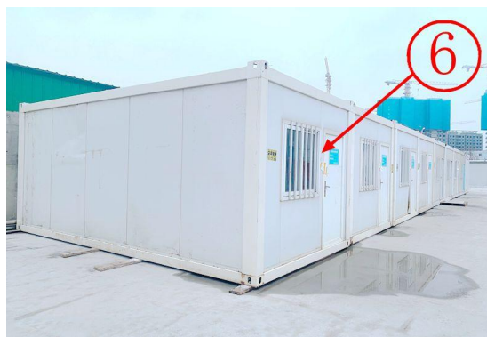
项目内未拆除建筑
