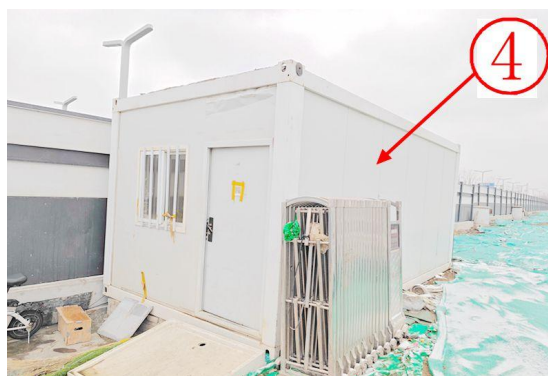
项目内未拆除建筑
