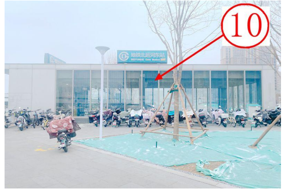
项目内未拆除建筑
