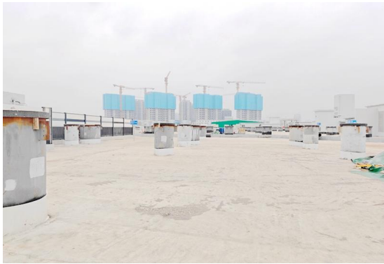
项目内基地平台
