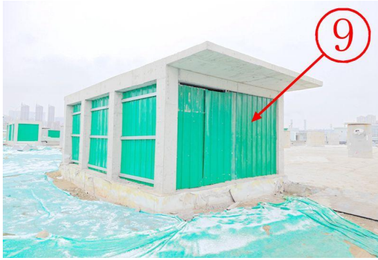
项目内未拆除建筑
