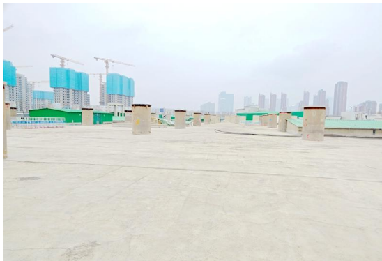
项目内基地平台
