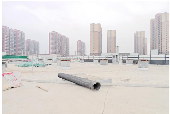
项目内基地平台
