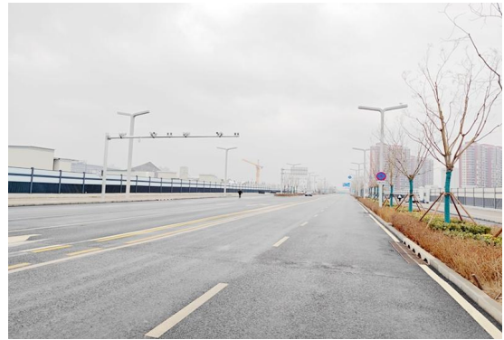
项目西侧现状道路
