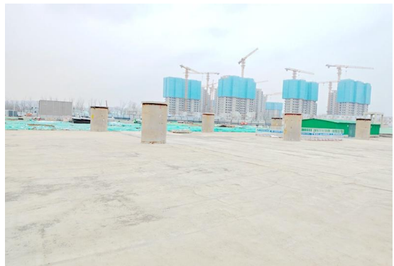
项目内基地平台
