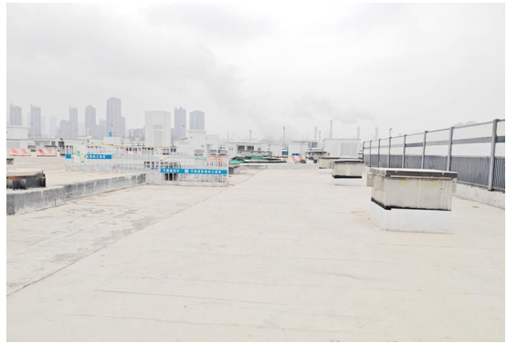
项目内基地平台
