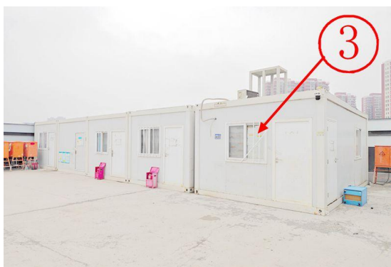
项目内未拆除建筑
